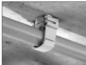
Cable conduits or light duty pipes
