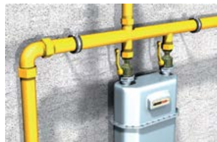
Крепление газовых расходомеров
