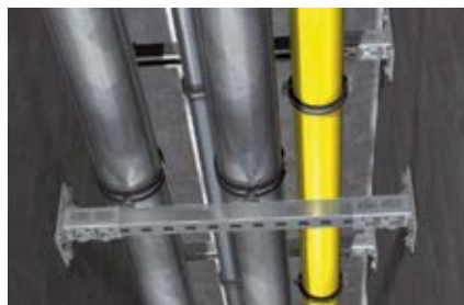
Крепление трубопроводов
