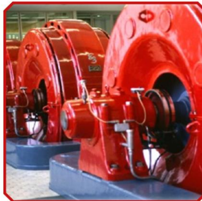
Крепление конструкций и оборудования
