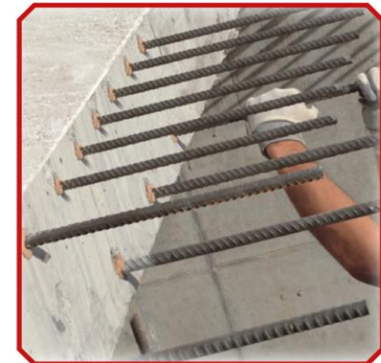
Устройство арматурных выпусков
