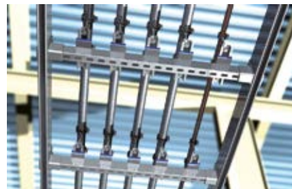
Скользящая опора на монтажной сетке
