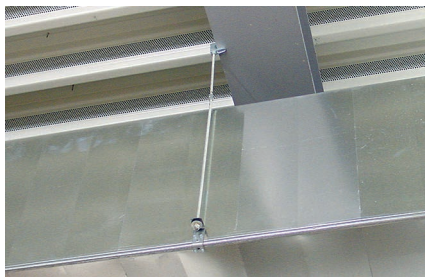
Воздуховод, закрепленный к стальной балке с помощью струбины
