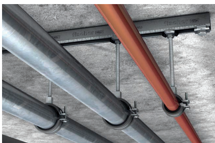
Крепление трубопровода с помощью монтажной шины
