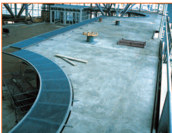
Монтаж малых архитектурных конструкций
