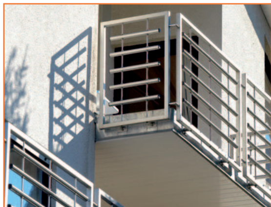
Монтаж балконных ограждений
