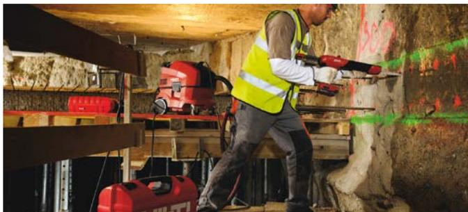
**HIT-Profi Anchor Kit** предназначен для профессиональной установки химических анкеров Hilti типа HIT. Данный набор идеально подходит для установки анкерных шпилек диаметром до 20 мм и глубиной установки до 250 мм. **Артикул: 2036988**
