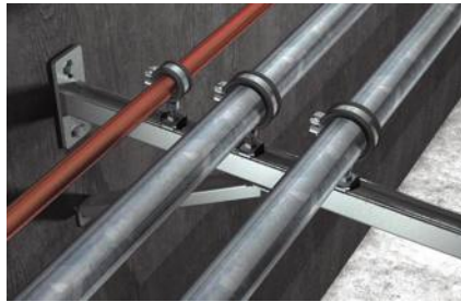
Крепление трубопровода к стене
