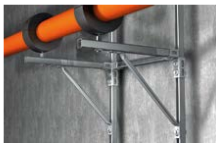
Усиление монтажной шины
