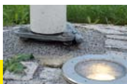
Крепление металлического флажштока к основанию из природного камня
