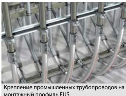
Крепление промышленных трубопроводов на монтажный профиль FUS
