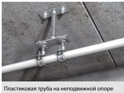
Пластиковая труба на неподвижной опоре
