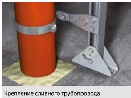
Крепление сливного трубопровода
