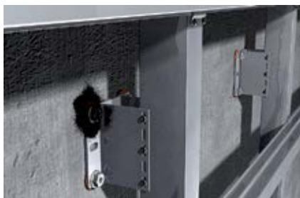
Герметизация головок шурупов
