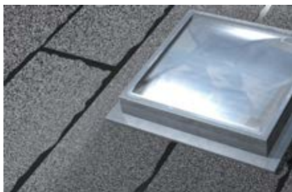
Герметизация вокруг мансардных окон
