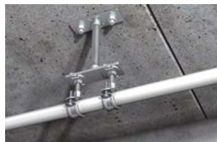
Неподвижное крепление пластиковой трубы
