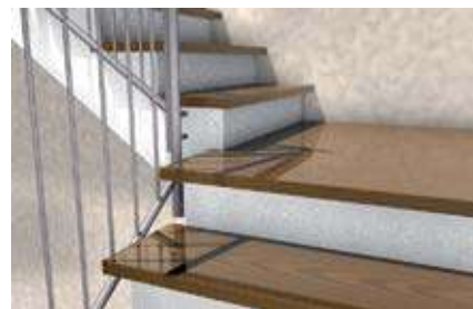
Лестничные ступени на бетонных лестничных балках
