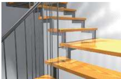
Лестничные ступени на стальных лестничных балках
