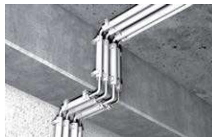
Крепление пластмассовых изоляционных труб
