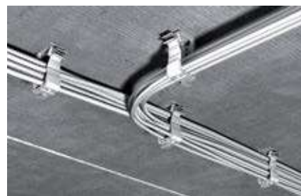
Крепление пучков кабелей
