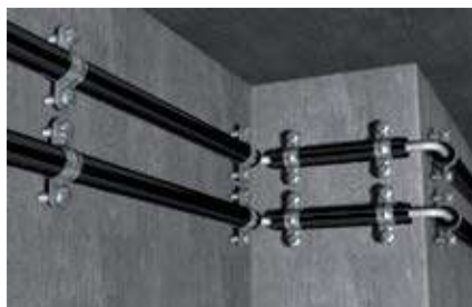
Крепление стальных трубопроводов в защитной оболочке
