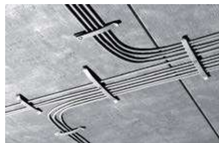
Крепление кабельных линий
