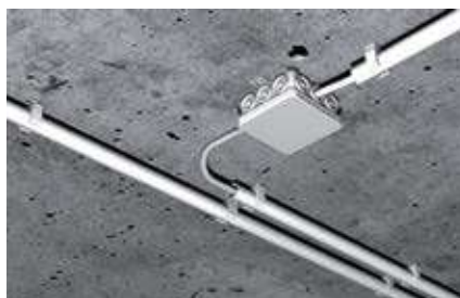
Крепление пластмассовых изоляционных труб
