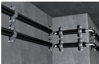
Крепление стальных трубопроводов в защитной оболочке
