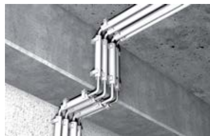
Крепление пластмассовых изоляционных труб
