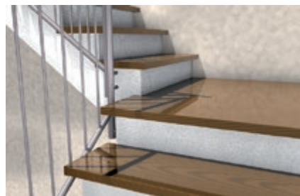
Лестничные ступени на бетонных лестничных балках
