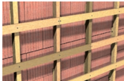
Крепление фасадных подконструкций
