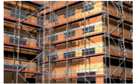
Фасадные строительные леса
