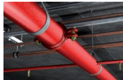
Системы аварийного пожаротушения
