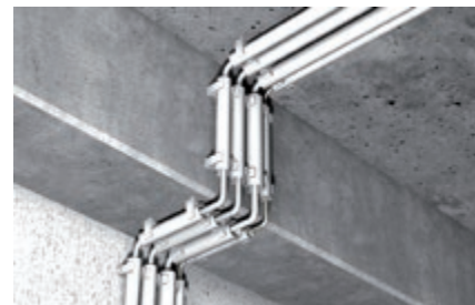
Крепление пластмассовых изоляционных труб
